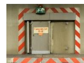
CTE Cross Passage Doors
